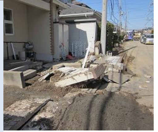
2011年3月11日液状化被災を受けた南栗橋
