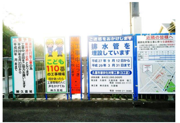
地下水位低下工法による液状化対策工事実施中
