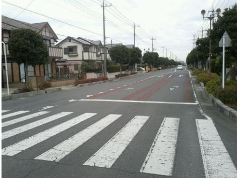
地下にパイプを埋め込み道路が凸凹
