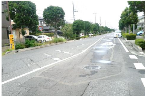
地下にパイプを埋め込み道路が凸凹
